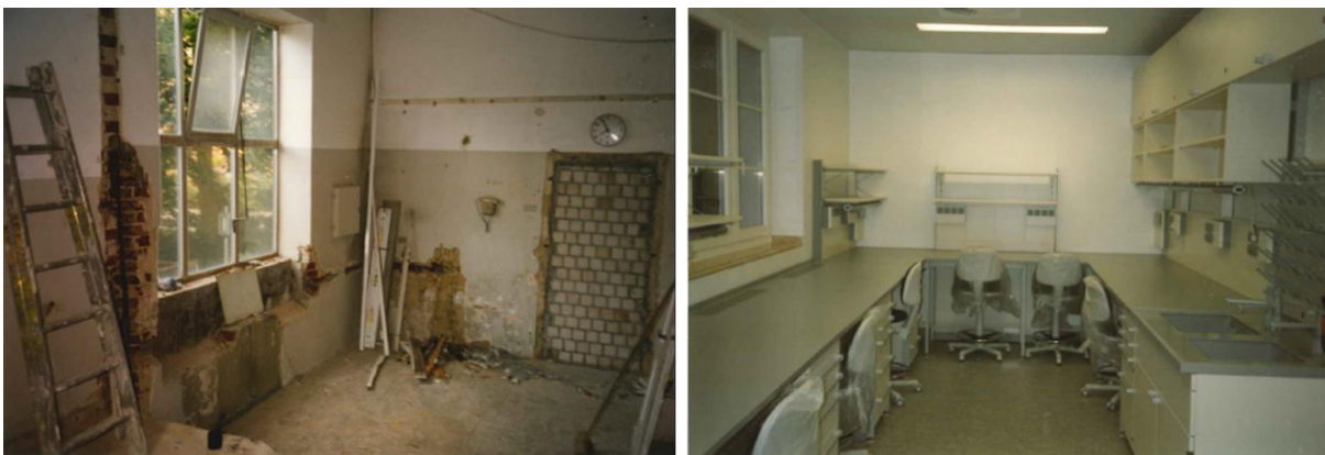
Bild 9: Umbau der Gärtnerei zur Molekularbiologie im Jahre 1998, vorher und nachher.
